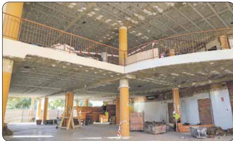
Estado de las obras de la nueva biblioteca de El Ejido. /DC
