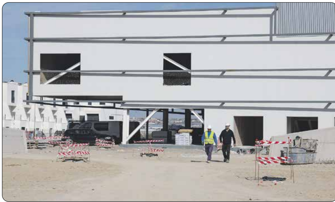
■ Obras en marcha del complejo deportivo que se levanta en el núcleo de Almerimar. /DC
