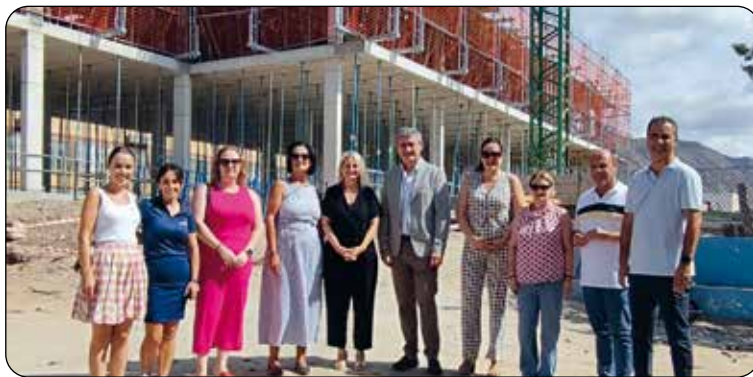
■ Una de las zonas en la que se están realizando los trabajos. /DC
