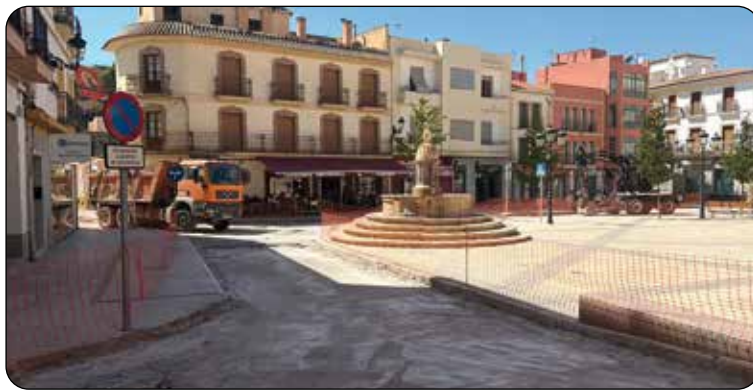
■ Una de las zonas en la que se están realizando los trabajos. /DC
