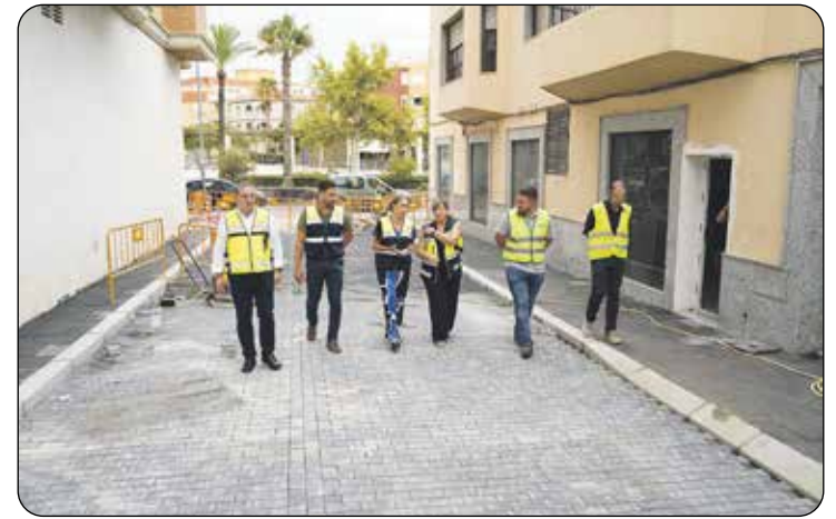
■ Visita a la zona en obras en el barrio de La Loma de la Mezquita. /DC
