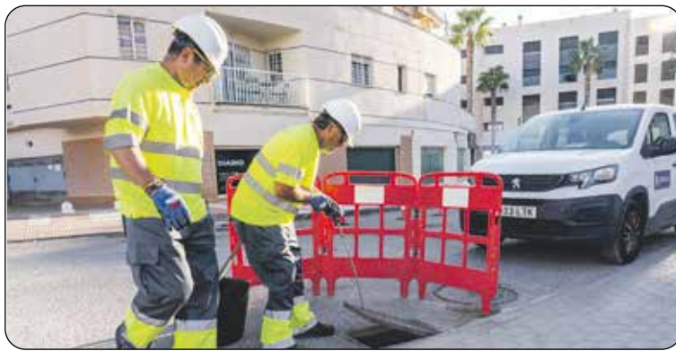
■ Operarios del Consistorio realizando los trabajos. /DC
