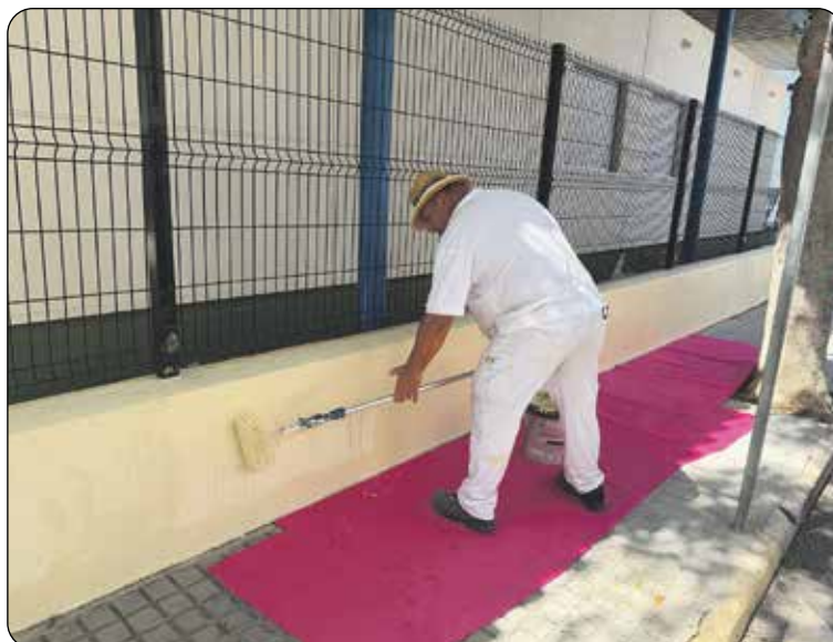
Tareas de pintura en uno de los colegios del municipio de El Ejido. /DC
