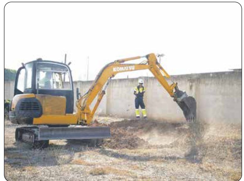
■ La maquinaria ya está actuando en la zona. /DC
