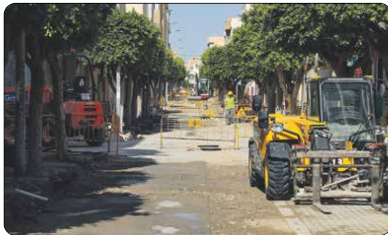
■ Obras en la calle Granada de El Ejido. /DC
