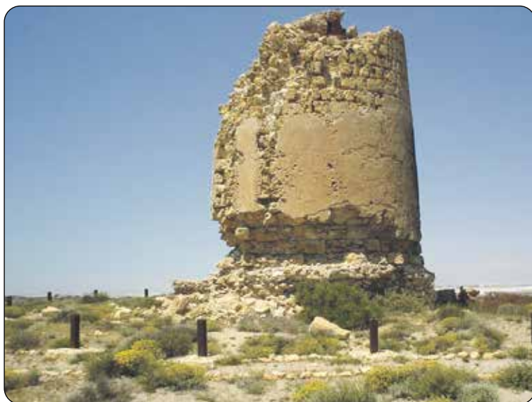
■ Torre de los Cerrillos. /DC
